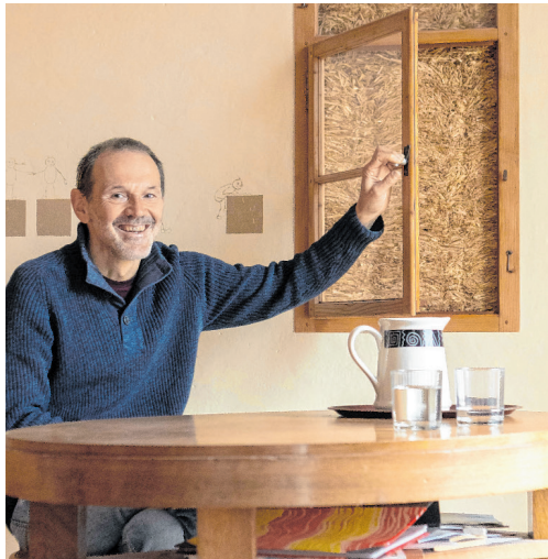
Gerhard Ritter dämmte sein Bürogebäude mit Stroh, das hinter dem Fenster zu sehen ist.
